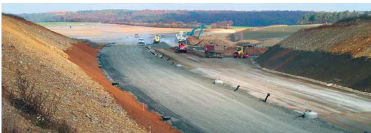
Novostavba A 71 – instalace systému Aqua-pipe
