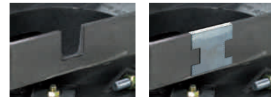
Otevřené odvodnění po dobu výstavby může být v případě potřeby uzavřeno závěrným plechem, položka č. 67308
