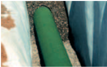
Vsakovanie pomocou potrubného vedenia Sicku-pipe:
