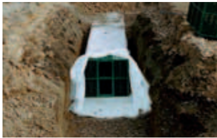
Vsakovanie pomocou blokov Rigo-fill:
