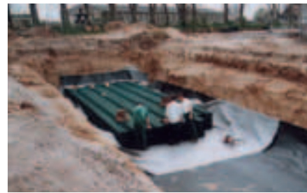
Zadržovanie dažďových vôd pomocou Rigo-fill blokov:
