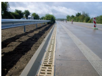
ACO Monoblock RD 200 V na A1 v Nemecku ako pozdĺžne odvodnenie diaľnice
